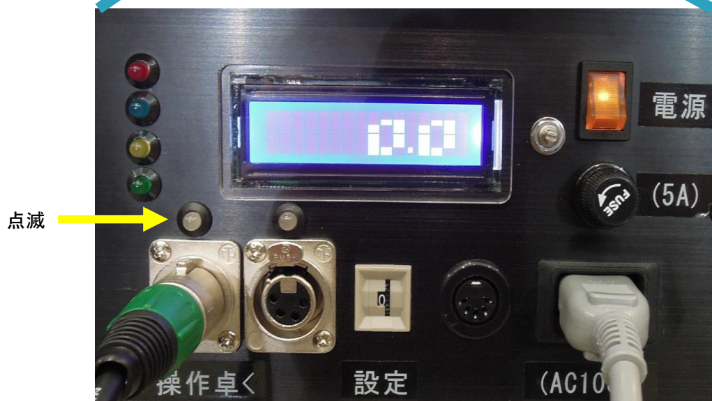
【表示機の接続パネル】
